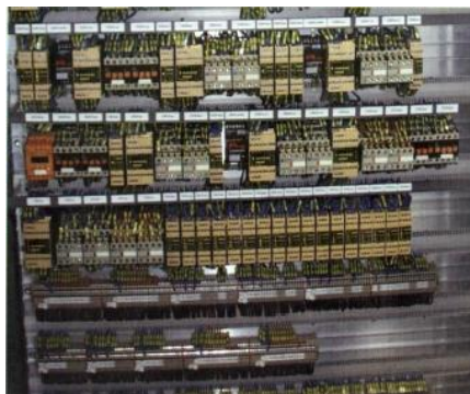
Figuur 8 Relaiskast met Jokab veiligheidsrelais
