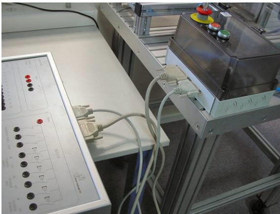
Figuur 2.4 Sub-D kabels
